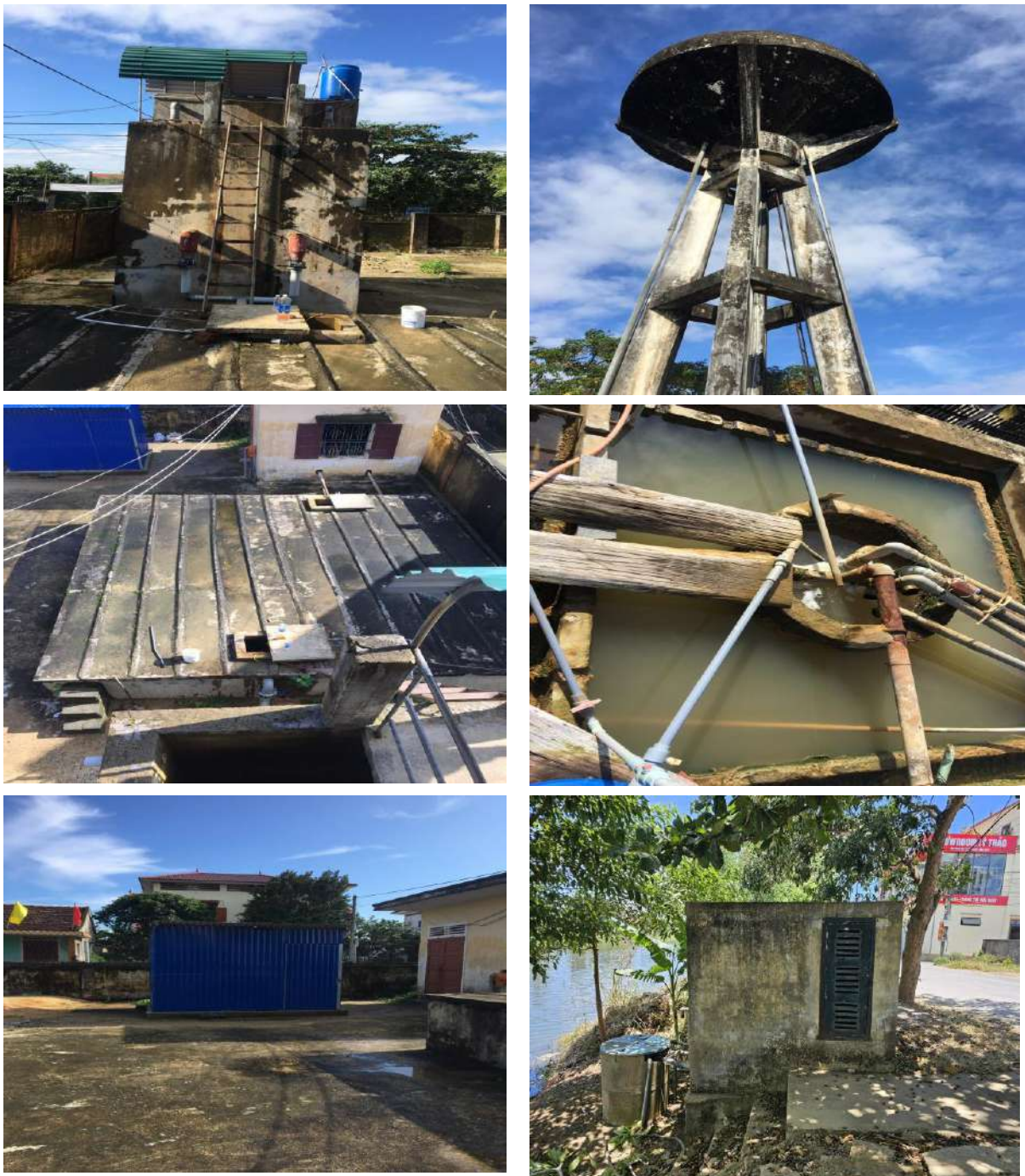
Hình 1.3: Hiện trạng công trình cấp nước thôn Đại Phong, xã Phong Thủy
