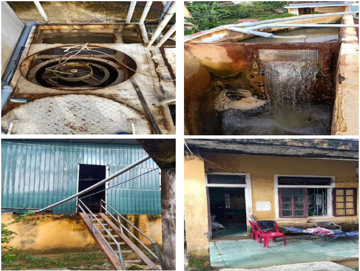
Hình 1.1: Hiện trạng công trình cấp nước xã Lộc Thủy
