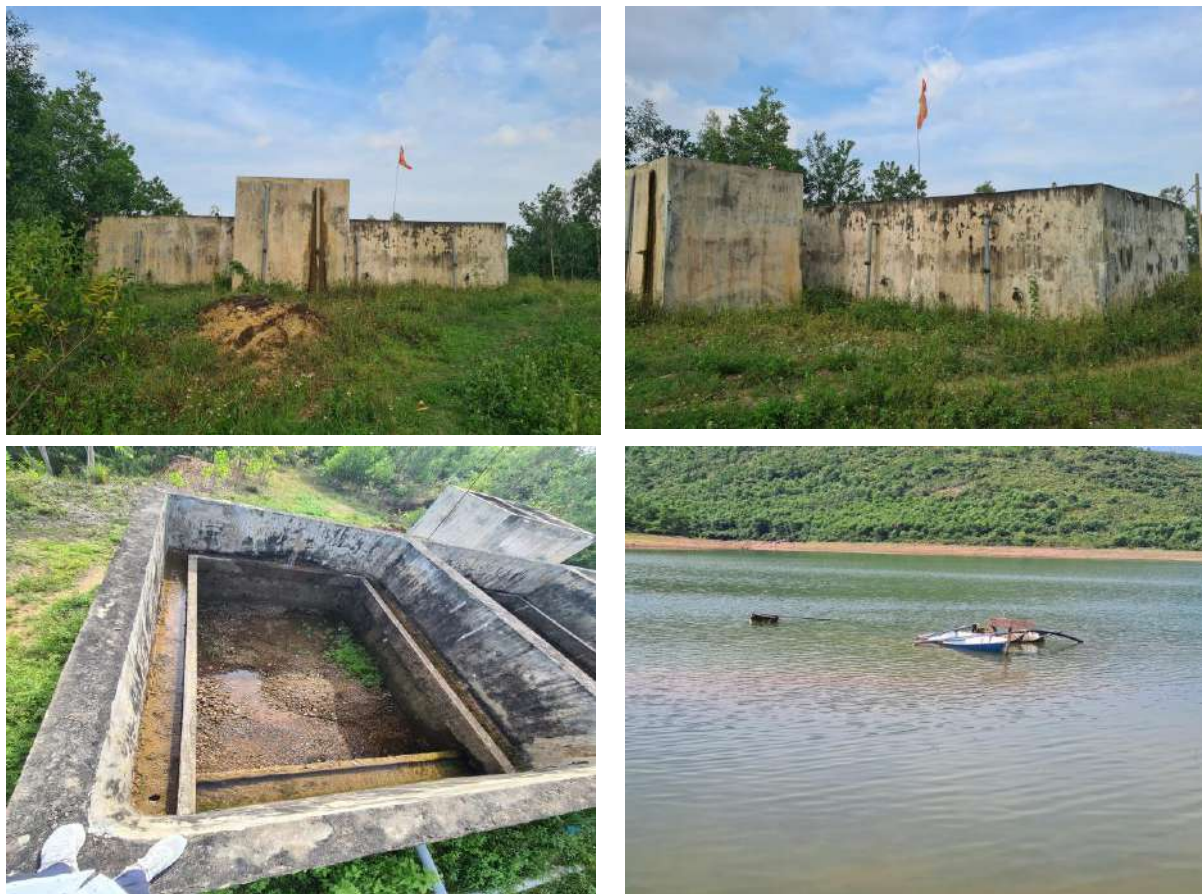
Hình 1.4: Hiện trạng công trình cấp nước xã Hạ Trạch
